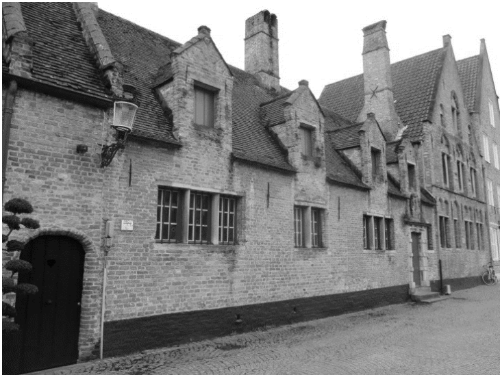
Afb. 6: De Godshuizen, ook dishuis genoemd, "De Pelikaen" aan de Groene Rei in Brugge.
